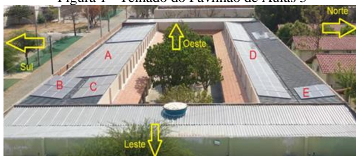
Figura 1 - Telhado do Pavilhão de Aulas 3
