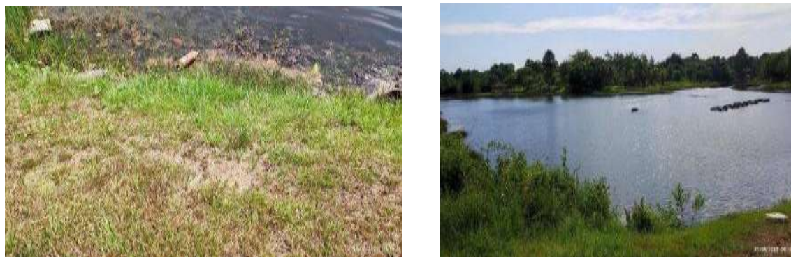
Figura 3 - Talude montante – Barragem Igarapé Sete Voltas/PA
