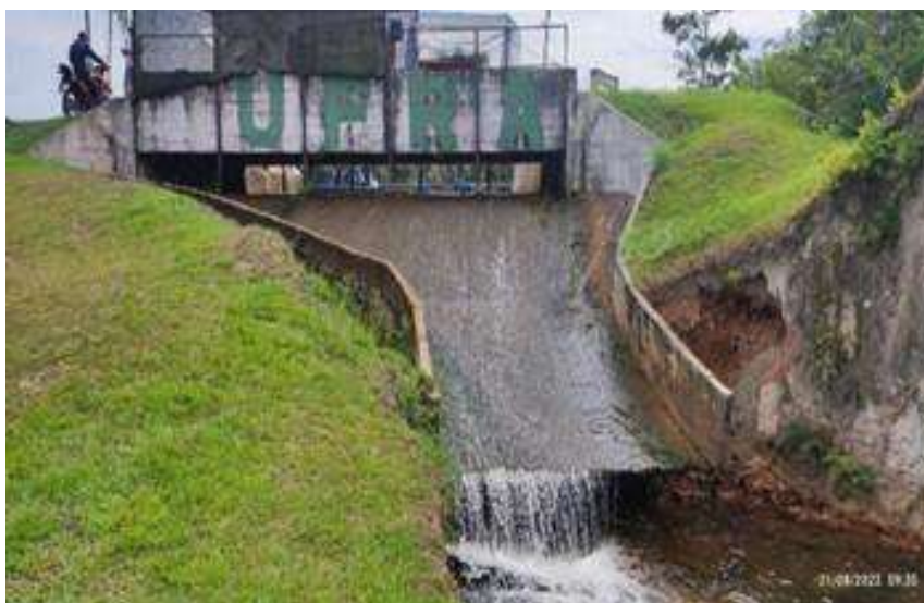
Figura 6– Vertedouro da Barragem Igarapé Sete Voltas/PA
