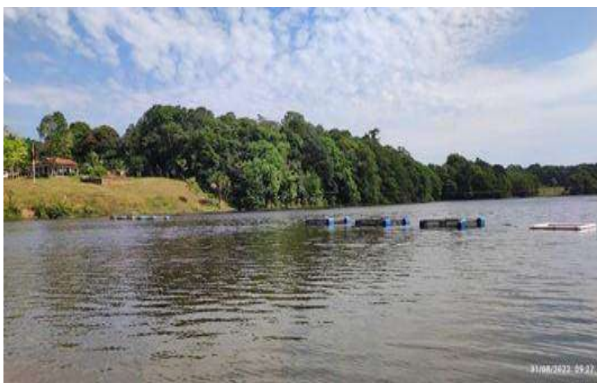
Figura 7 – Reservatório da Barragem Igarapé Sete Voltas/PA
