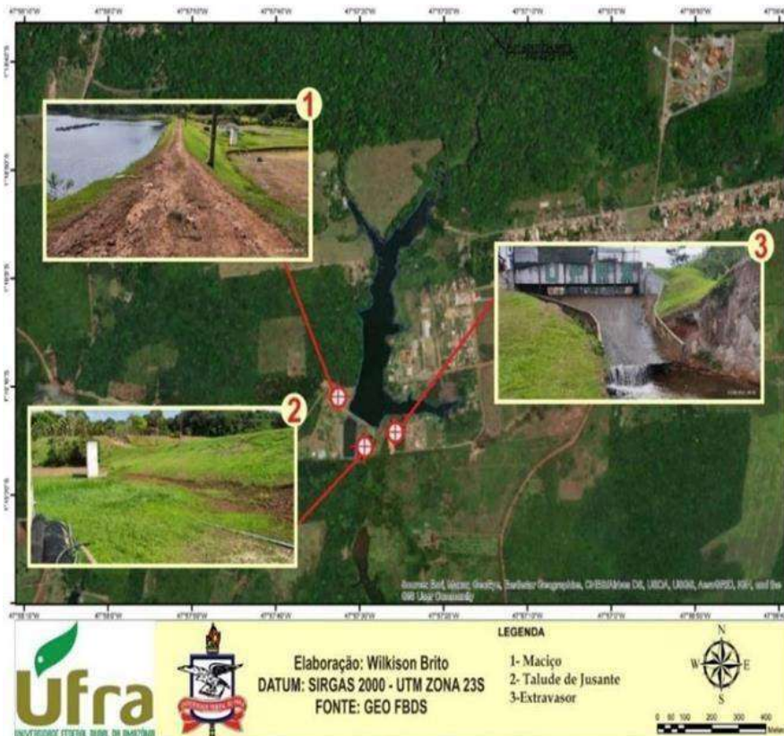
Figura 2 - Elementos constitutivos da barragem do Igarapé Sete Voltas
