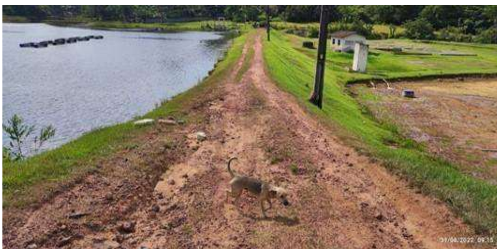
Figura 5– Crista da Barragem Igarapé Sete Voltas/PA
