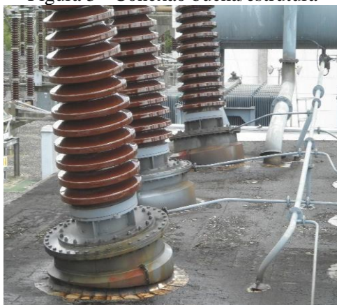
Figura 3 - Conexão bucha/estrutura
