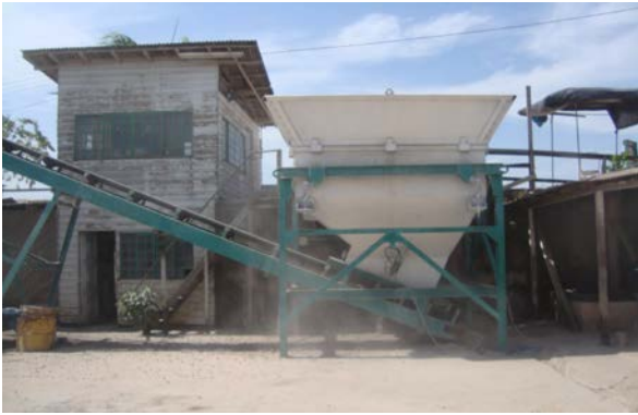
Figura 7 – Usina de concreto
