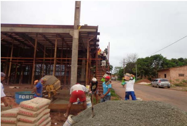
Figura 8 – Concretagem com betoneira
