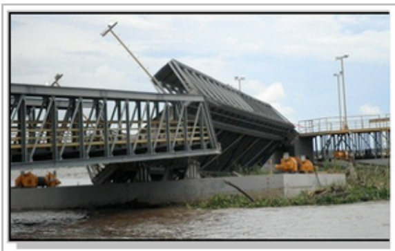
Figura 1 - Incidente ocorrido no Porto de Manacapuru/AM Fonte: DEC – Departamento de Engenharia e Construção - Exército Brasileiro, 2005.
