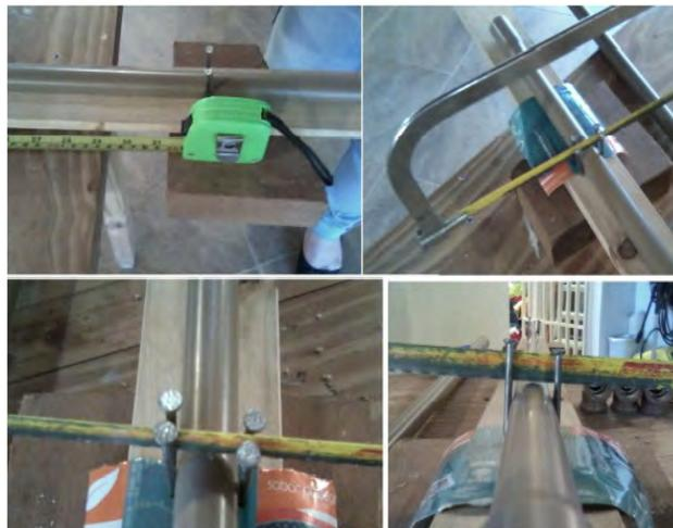
Figura 8 – Corte do tubo de PVC. (AUTOR, 2012)
