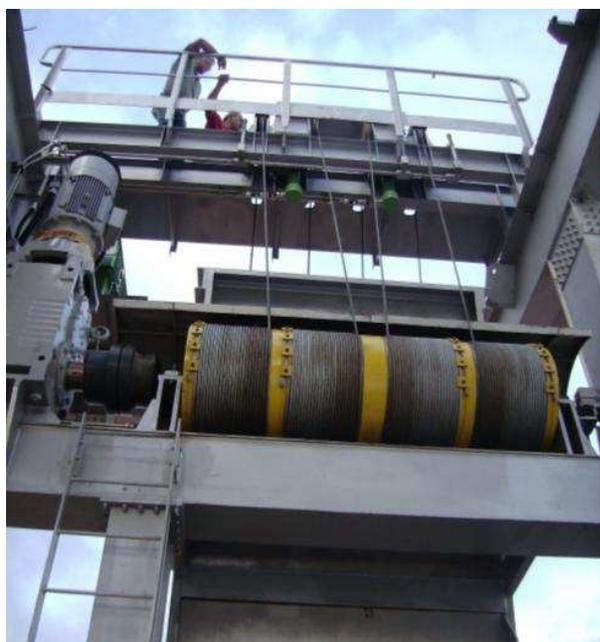
Fig. 4 – Plataforma e motor-tambor de levantamento do rastelo (do autor)
