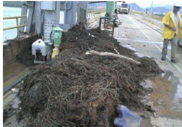
Fig. 2. Detritos existentes na tomada d'água
