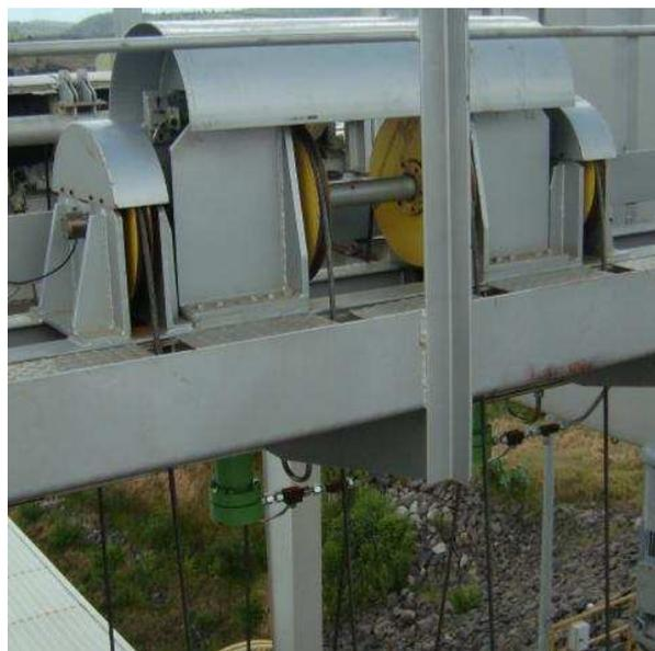
Fig. 6 – Sistema hidráulico para abertura da concha do rastelo (do autor)
