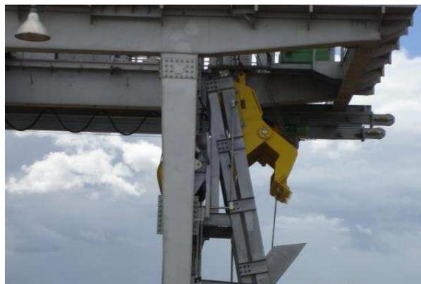
Fig. 5 – Rampa para o direcionamento dos detritos após abertura do rastelo (do autor)
