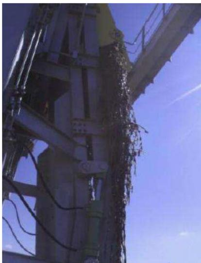
Fig. 7 – Operação de limpeza da grade com o rastelo
