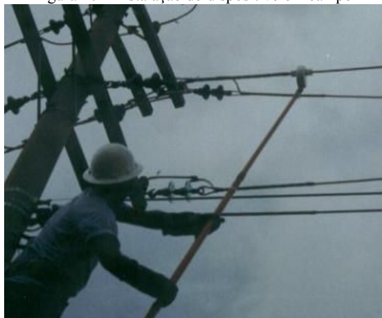
Figura 10 – Instalação do dispositivo em campo
