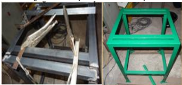
Figura 9 - Confeção da Bancada de fixação.
