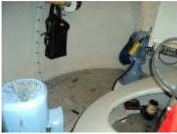
Após a montagem dos equipamentos, inicia-se a lubrificação das pás, que será feita por apenas um colaborador. Aqui, a graxa a ser utilizada é a Gleitmo 585K.
