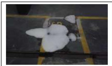
A figura 4 permite a visualização de retorno de espuma para o piso do subsolo do edifício C, através de uma caixa de gordura com tampa de concreto armado contendo aberturas e condições precárias de conservação. Note-se que
