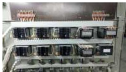
Figura 10 - Controladores microprocessados modulantes instalados
