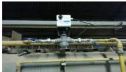
Figura 8 - Servomotor já instalado no local
