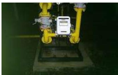
Figura 12 - Medidor digital usado para conferir o consumo de gás
