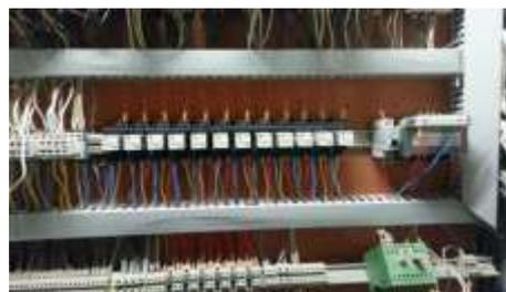
Figura 9 - Relés e transformador já instalados
