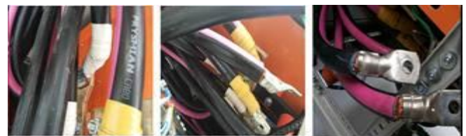
Figura 7 – Pontos onde apresentam falhas nos componentes BETAS
