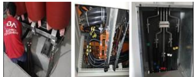
Figura 6 – Pontos de execução das atividades do circuito elétrico BETA
